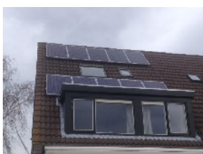
8 panelen op woonhuis Hamelijck
