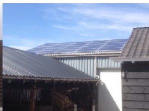
40 panelen op loods voor woonhuis en bedrijf Loef
